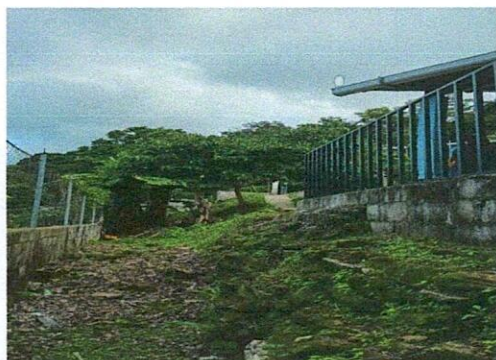
Foto 3: mejoramiento del cerco perimetral colocando baranda metalica para resguardar la integridad fisica de los niños y niñas de la etapa 4.
