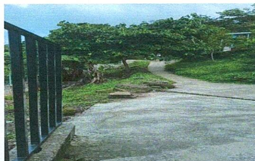
Foto 4: mejoramiento del cerco perimetral colocando baranda metalica para resguardar la integridad fisica de los niños y niñas de la etapa 4.
