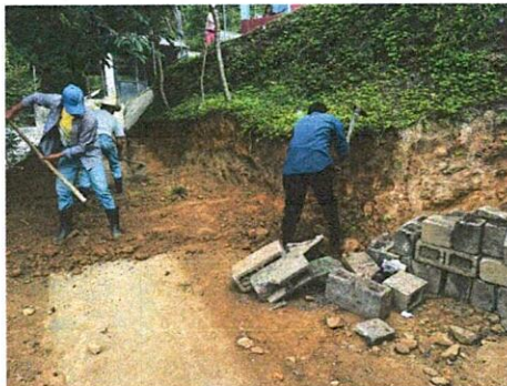
Foto 2: Mejoramiento de torta de cemento para que los niños y niñas tengan una superficie de piso evitando la tierra y el polvo.
